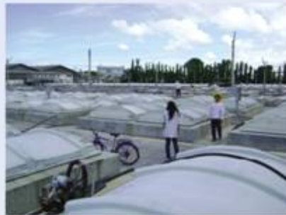
Pumping fish source ปั๊มหากน้ำปลา ในโรงงานน้ำปลา
